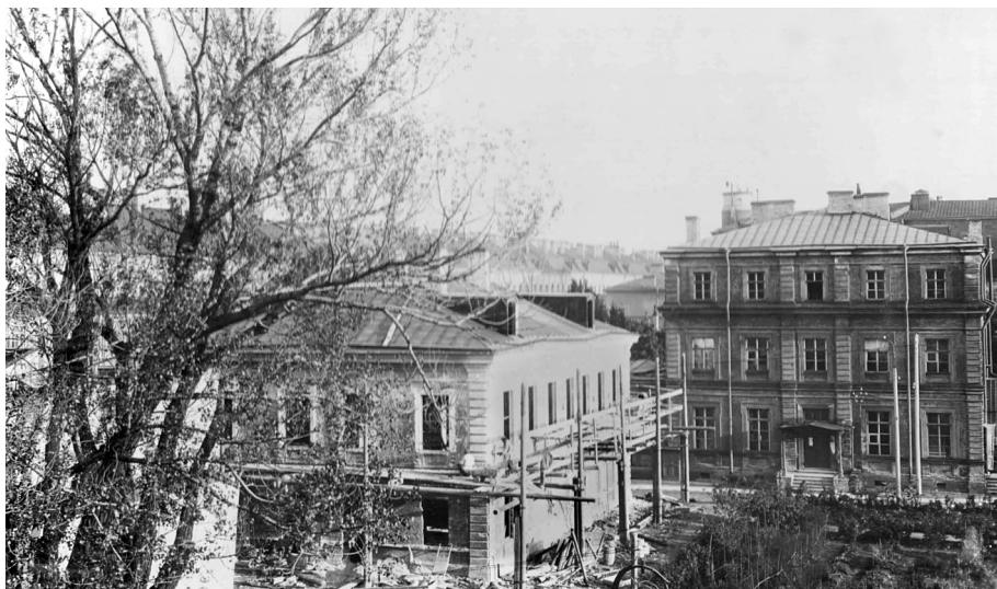
Рис. 9. Строительство криптогамического кабинета (1896–1897) Из архива музея Санкт-Петербургского университета.
